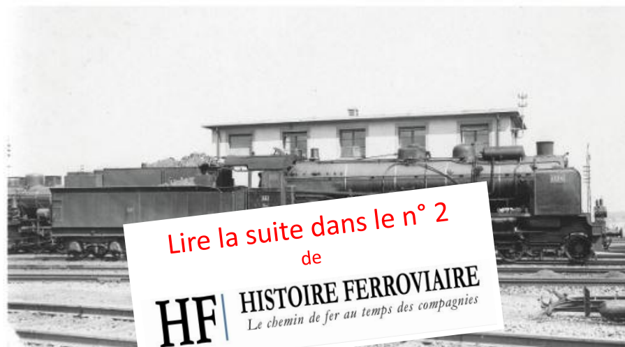
Photo n° 5. La S14 1324, au tender modifié avec soute à eau rehaussée à l'arrière en partie supérieure, soute à charbon agrandie par des rehausses métalliques latérales et système d'arrosage de la plate-forme en prolongement arrière de la toiture de la cabine. Collection Hansjürgen Wenzel.
